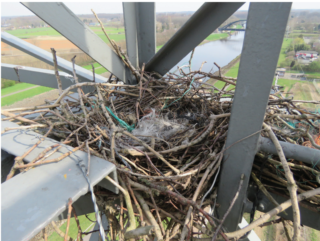
Foto 4.3. Oud kraaiennest waarin niet-natuurlijk nestmateriaal zoals prikkeldraad is verwerkt in 110 kV mast bij Zutphen, 10 april 2018. Foto: Peter de Boer.
