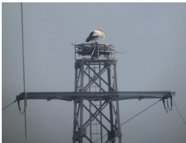
Foto 5.2 en 5.3. Nestplatform op mastlichaam bezet door Ooievaar in de Bemmelse polder. Foto's: Berend Voslamber.
