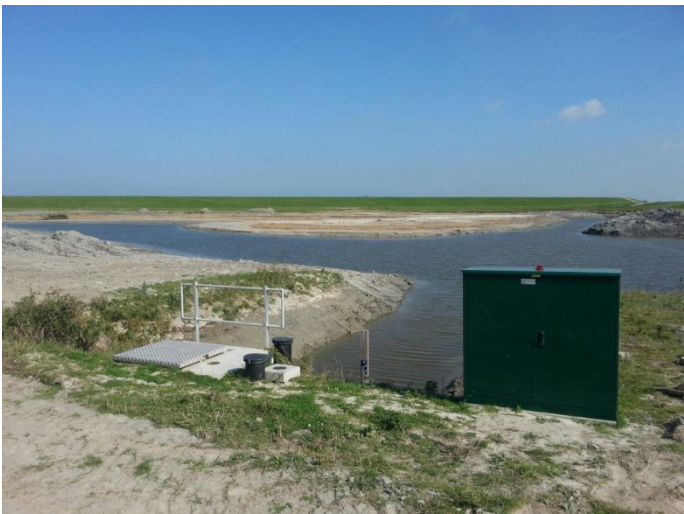
Foto 1. Pompgemaal dat zorgt voor het pompen van zoutwater uit de oostelijke waterplas in het nieuwe westelijke gedeelte (Arjan Hendriks).
