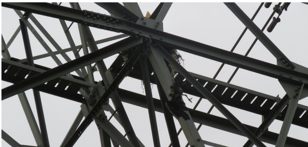
Nest van Raaf in hoogspanningsmast in zuidelijk deel van het Reve-Abbert. Het nest bevatte één jong dat het niet overleefde en met de poot vast zat in het nest. Op 4 juni bungelde het onder het nest en hing er in oktober nog steeds zo bij, 14 oktober 2025 (Symen Deuzeman).
