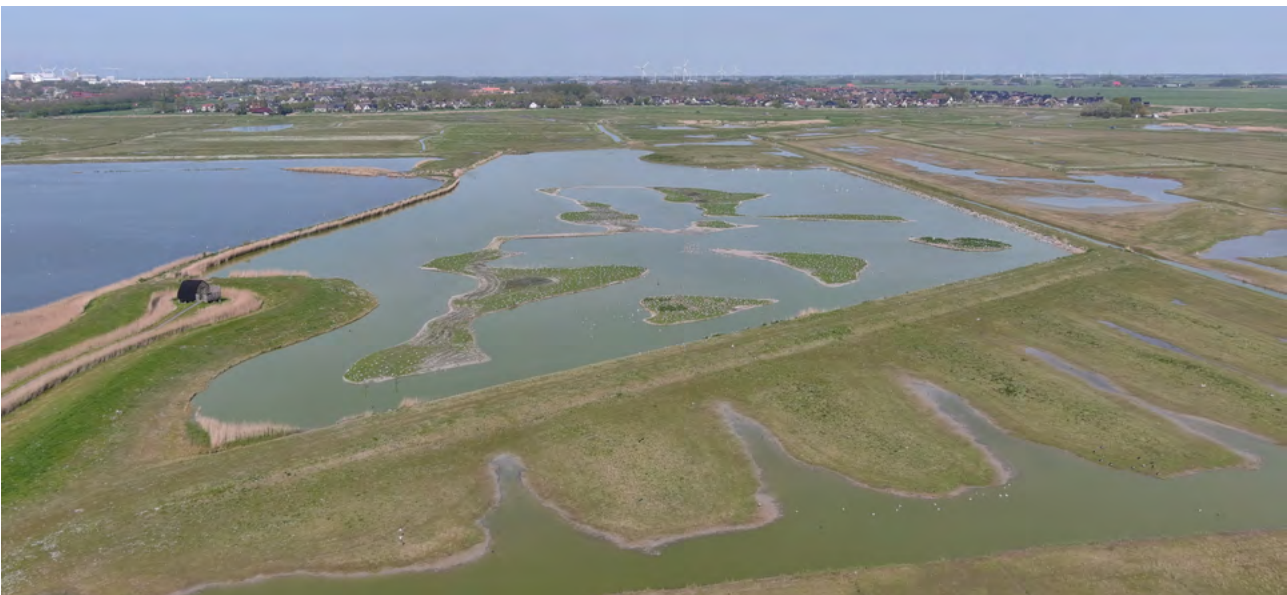
Figuur 2.3. Hegewiersterfjild met op de achtergrond Harlingen. Dit gebied bestaat uit grasland en broedeilanden. Aan de linkerkant van de foto is een vogelkijkhut zichtbaar.
