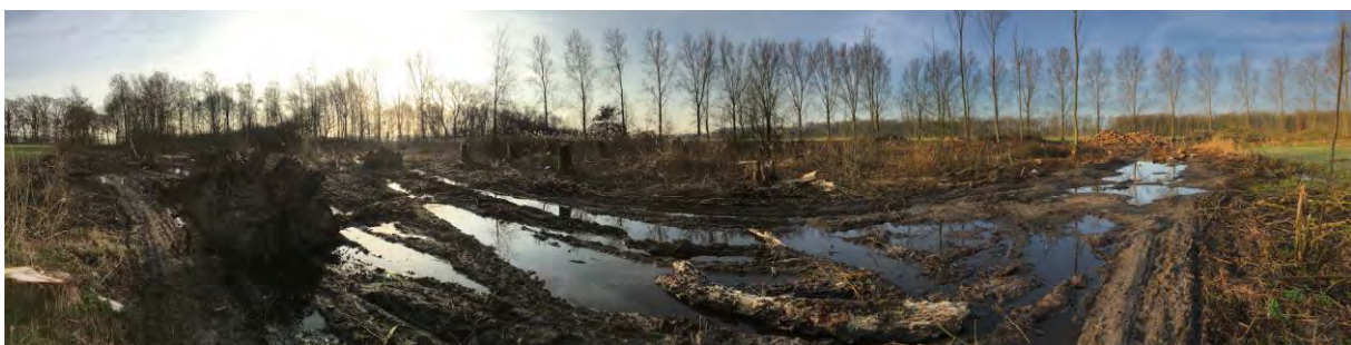
Op verschillende plekken in De Biezen vonden werkzaamheden plaats in het vroege voorjaar.
