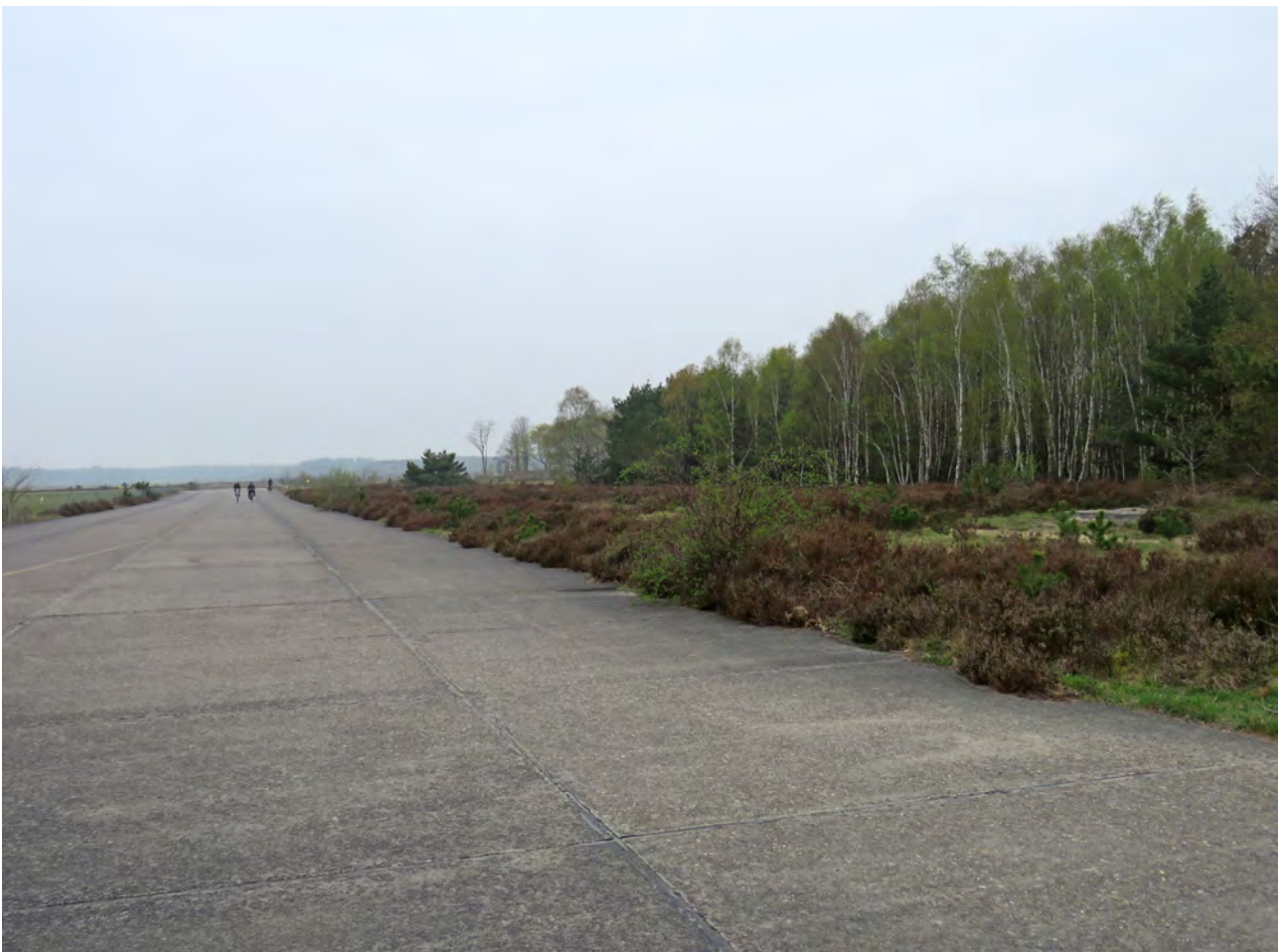
Het oost-west verlopende deel van het huidige Wethouder Lemmenpad over de rolbaan van het cargoplatform naar de Middle East. In het voorstel voor de nieuwe variant van het pad zal dit deel komen te vervallen. De oost-west tak van deze nieuwe variant komt door de heidestrook en het bos aan de rechterzijde van de rolbaan te liggen.
