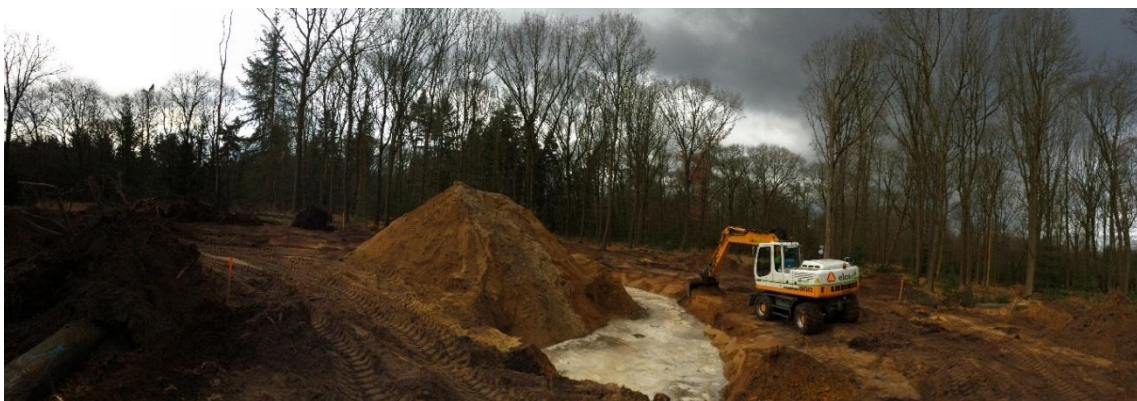
Graafwerk voor een van de poelen
