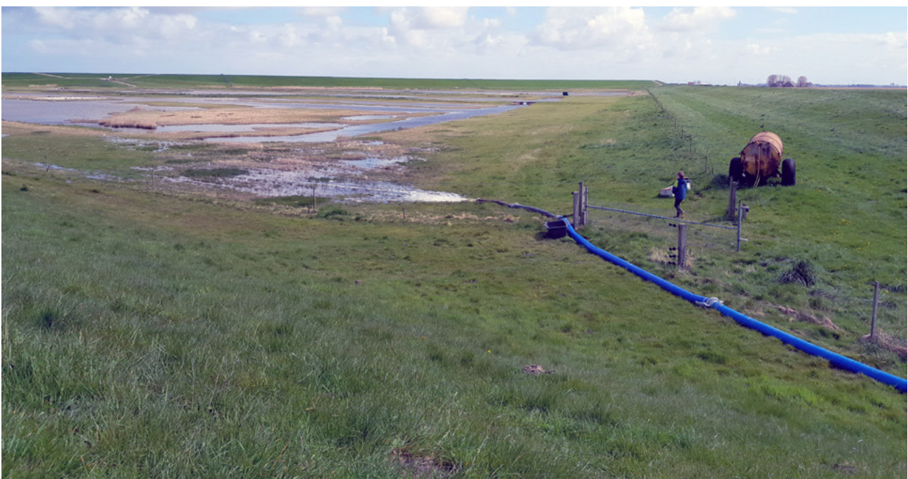
Foto 1. Inlaat van water (blauwe slang) uit omringend gebied in het westelijke deel van de Klutenplas, met als doel een voldoende hoog waterpeil te behouden, 25 april 2023 (Peter de Boer).
